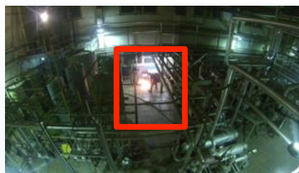
Обнаружение огня и дыма
